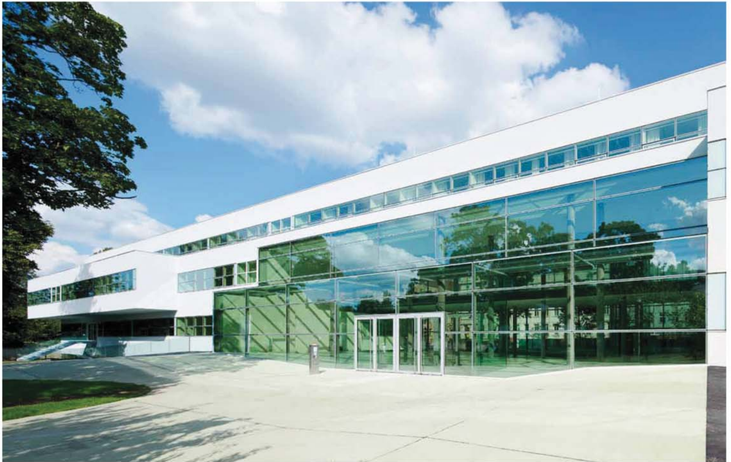
Nord-West-Seite der Krankenpflegeschule von lichtblau.wagner architekten. Die Klassenzimmer sind zum Vorbereich hin orientiert, betreten wird die Schule über ein gläsernes, zweigeschoßiges Foyer. Fotos: Rupert Steiner
